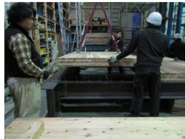
鉄骨フレームのスタッド位置にあわせてCLTパネルを設置
