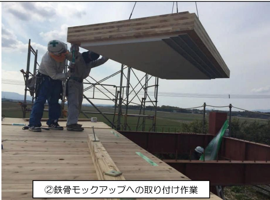
②鉄骨モックアップへの取り付け作業
