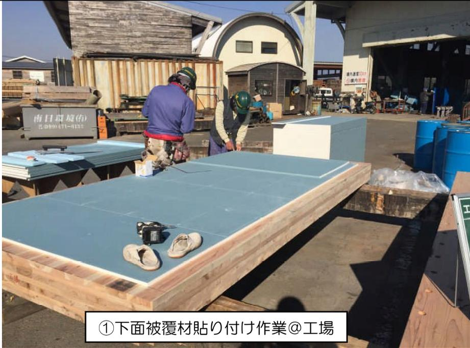
①下面被覆材貼り付け作業@工場
