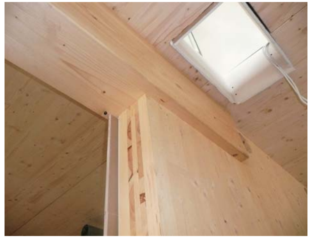
建物内部。壁にCLT、梁に集成材が使われている
