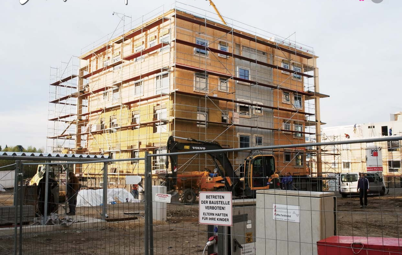
CLTの建築現場(オーストリア第2の都市グラーツ市ヴェッツェルスドルフ地区)
