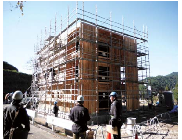
CLTを構造躯体に使った国内初の事例として注目されている
