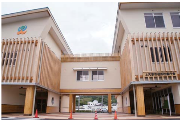
庁舎と保健センターは2階の渡り廊下でつながっている
