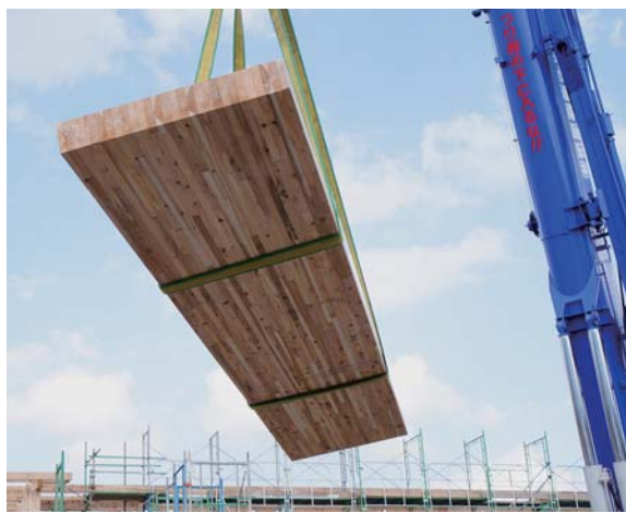
種子島のせいざん病院様で使用した集成材厚板パネル (厚み 120mm × 幅 800 mm × 長さ 6m)
