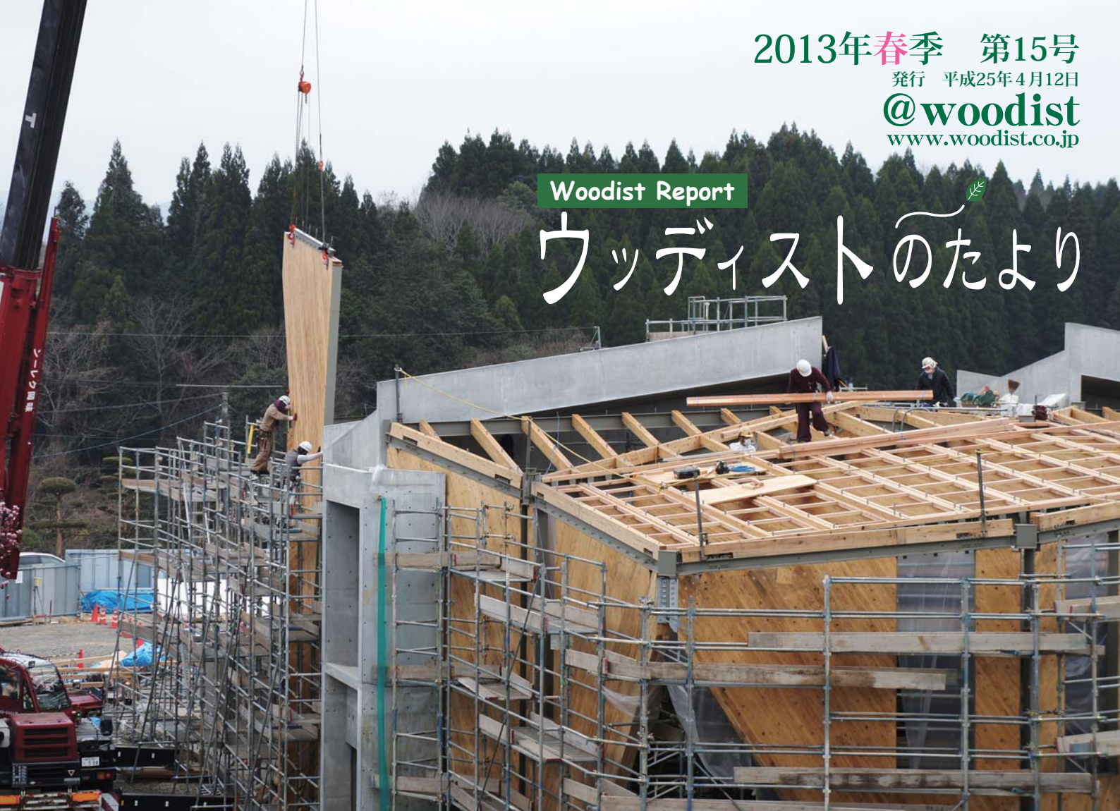
球磨工業高校管理棟改築工事(3/17現場見学会にて撮影)
