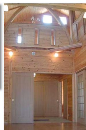
上：幅はぎ材 製造状況 右：むく面材を使用した内壁
