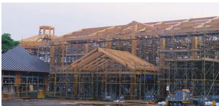
南種子町 中平小学校 町有林材を大断面集成材に加工し構造材として利用
