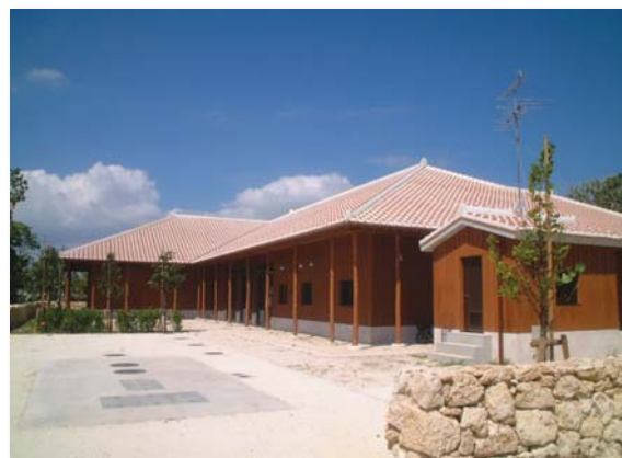
竹富島ゆがふ館(上:内観 下:外観) 構造材の大断面集成材をはじめ使用した木材全てを ホウ酸塩注入で防腐処理
