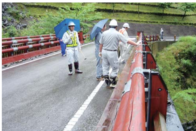
雨天の中での点検状況
